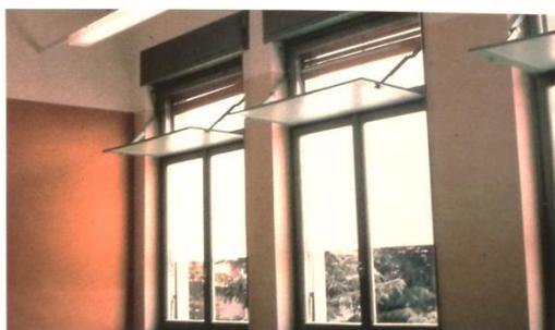
**Figura 25 . Aula di Ispra (Varese) con la vista delle finestre sottoposte al controllo della luce naturale. Si notano: lo spazio libero che permette di vedere all'esterno e in alto il piano speciale che riflette la luce del sole verso il soffitto. Il sole può illuminare direttamente solo la zona immediatamente antistante alla finestra, zona che non viene occupata dai banchi.**
